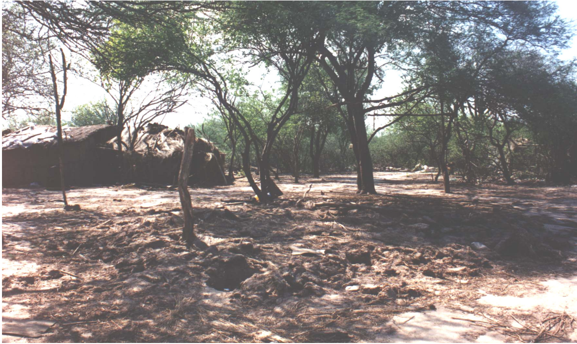
Foto 12. Viviendas desmoronadas en Lote 42 tras la muerte de Pablo
