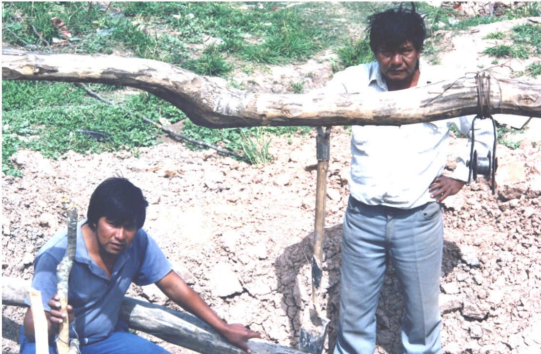
Foto 8. Marcelino y su hermano construyendo un pozo para extraer agua (Lote 47)
